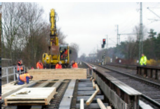
Einbau der Gleishilfsbrücke über den Hüttenweg (22.11.2009)
